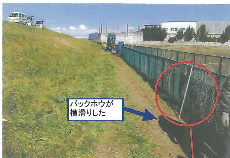
傾斜地での作業状況
