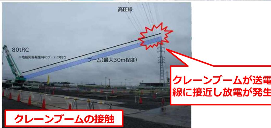
接触事故防止のための当社の取組みの一つとして、図面が存在しない既存建物、狭小敷地での電柱と架空線、高圧線などを対象に3Dスキャナによる実測・モデル化を行っている。実測データの活用により、架空線との干渉を避けた詳細な揚重計画立案が可能となる。
