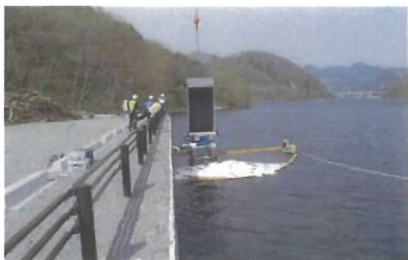
クレーンの引き上げ作業状況
